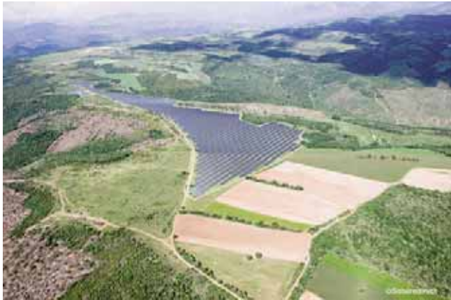
Solairedirect 1 : Solairedirect, site de Les Mées 1 – 12 MWc Installation en plein champ
